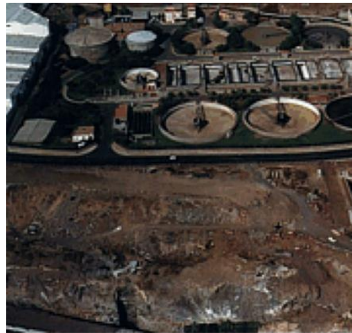
Estación depuradora de aguas residuales
