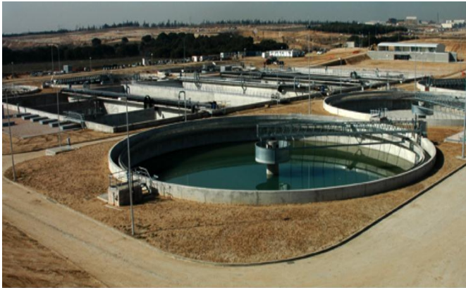
Vista panorámica de la EDAR La Reguera, Madrid
