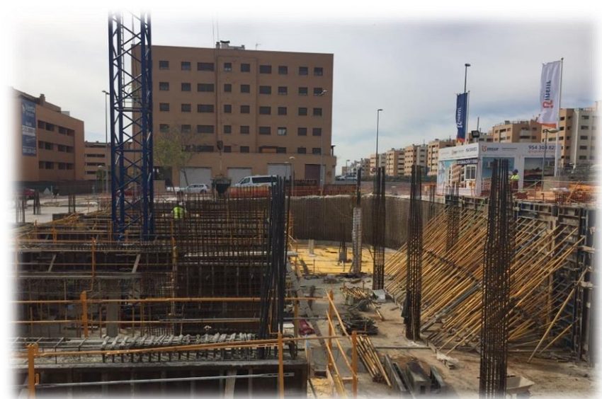
Edificio Galileo (Mairena del Aljarafe - Sevilla)
