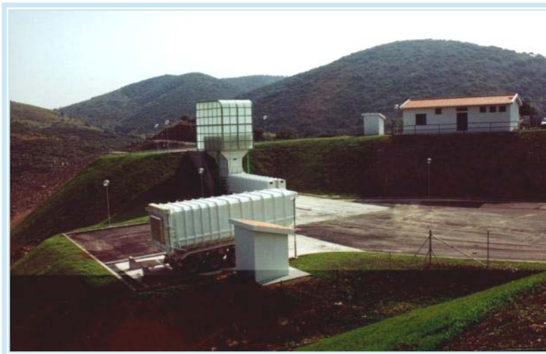
Estación de transferencia -Torre de Moncorvo (Portugal)
