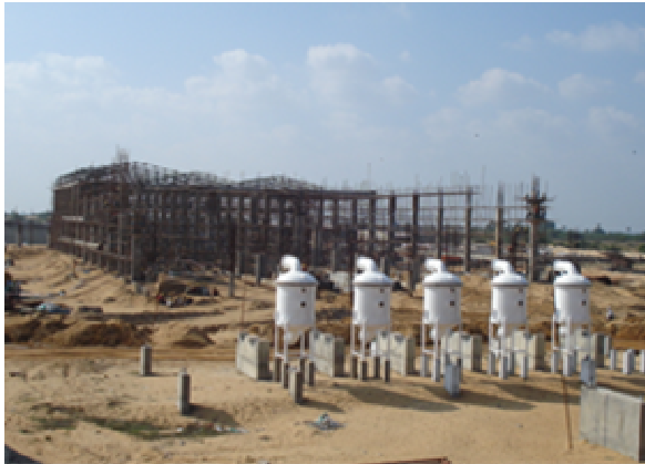
Planta desaladora en Chennai (India)
