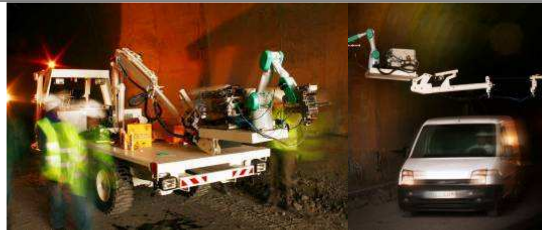
Preparación del robot en el interior de un túnel y operando con tráfico
