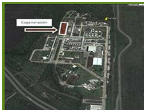
Cogeneración Dynasol 57 MW, COD 2017
