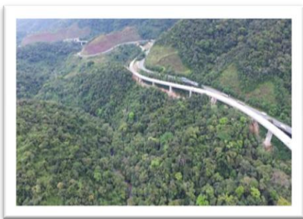
Duplicación de Serra do Cafezal (Autopistas Régis Bittencourt )
