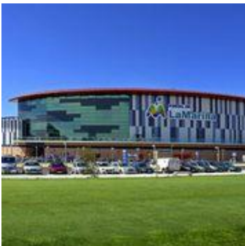
Fachada Exterior del Edificio
