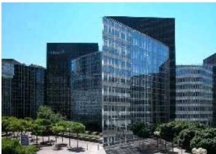
Edificio de oficinas "Tour Coface" (Paris)
