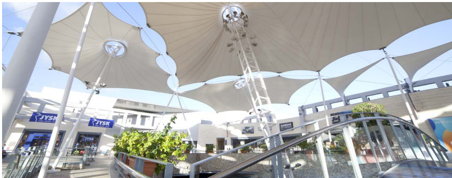
Centro Comercial Vistahermosa (Alicante)
