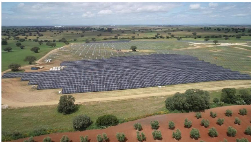
Construcción de la planta solar Alvarado en el sur de España
