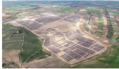
Bargas (50 MW) EPC para tercero - España
