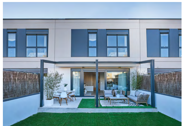
Proyecto Merían, Torrejón de Ardoz. Promoción 100% industrializada.
