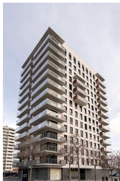
Torre Estronci 99 (L'Hospitalet de Llobregat)
