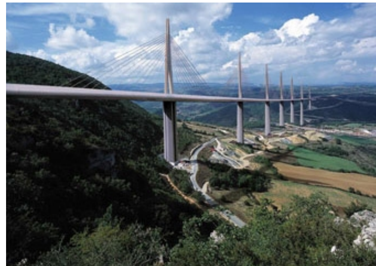
Viaduct Millau. Francia
