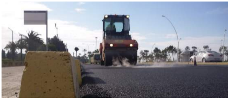
Pavimentación experimental. Puerto de Huelva España.
