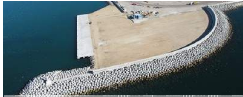
Cubipodos empleados en la ejecución del dique de abrigo en el Puerto de Málaga.
