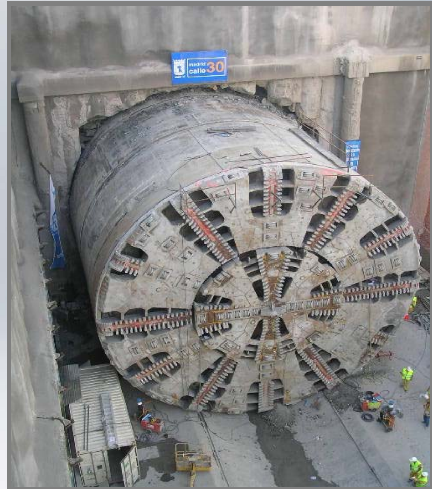
Túnel M-30, Madrid (2006)
