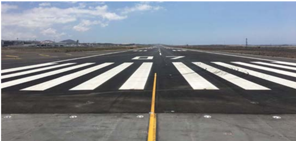
Pista repavimentada Aeropuerto Tenerife Sur
