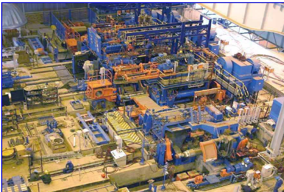
Cimentaciones laminador en frío SZ nº3
