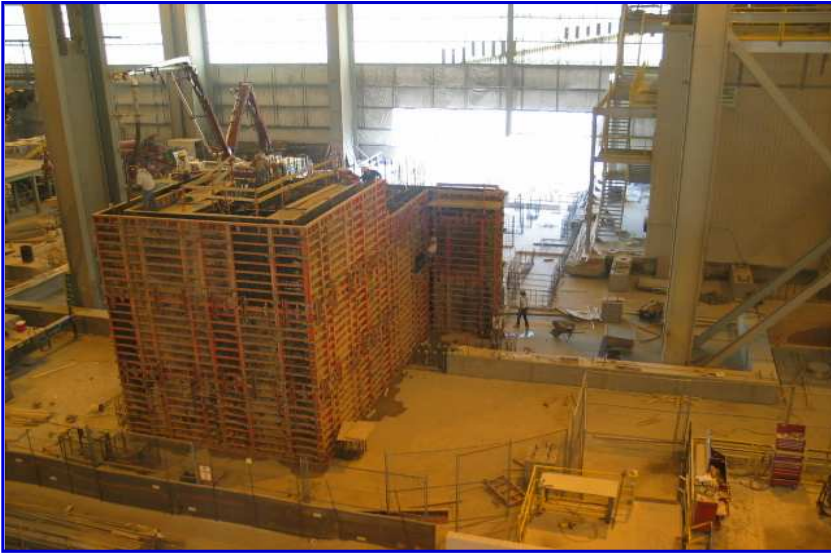
Montaje colada continua de palanquillas
