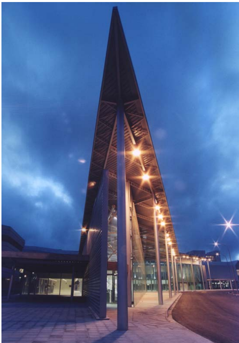
Aeropuerto de Mallorca
