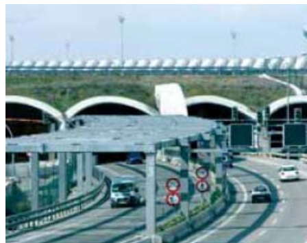
TÚNELES AEROPUERTO DE BARAJAS, MADRID
