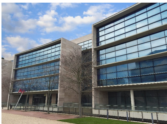
Foto: Axiare Patrimonio. Edificio en la Avenida Can Fatjó dels Aurons
