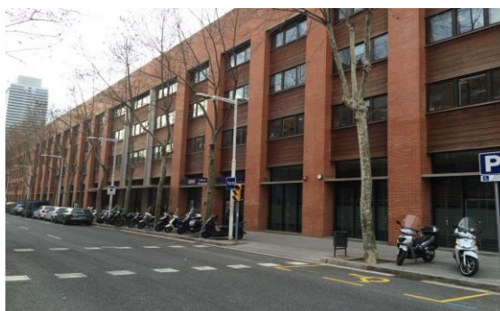
Vistas aérea y frontal del edificio
