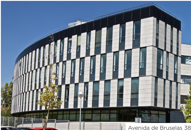
Avenida de Bruselas 38
