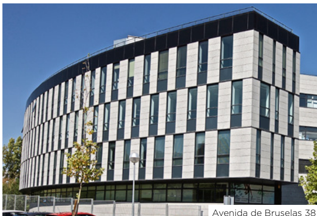
Avenida de Bruselas 38
