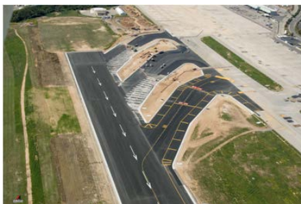
Imagen 24. Nuevas calles de acceso. Aeropuerto de Palma de Mallorca
