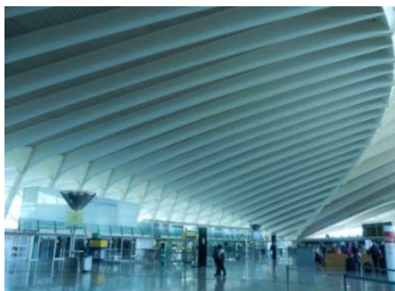
Imagen 13. Pintura estructura metálica. Aeropuerto Bilbao
