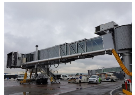
Imagen 31. Nueva pasarela. Aeropuerto AS Madrid-Barajas
