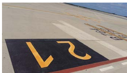
Imagen 32. Reparaciones en plataforma. Aeropuerto de Menorca
