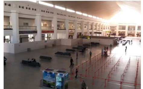
Imagen 15. Sustitución de solería en terminal T2. Aeropuerto de Málaga-Costa del Sol
