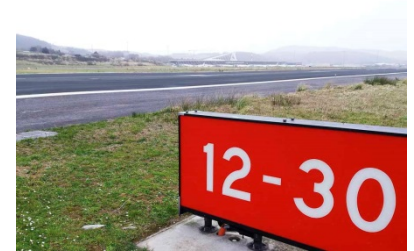
Imagen 44. Campo de vuelos. Aeropuerto de Bilbao
