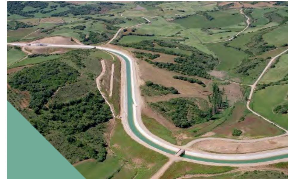
Canal de Navarra
