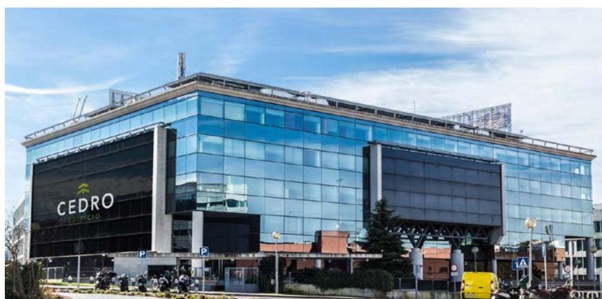
Foto: Edificio Cedro, propiedad de Axiare Patrimonio
