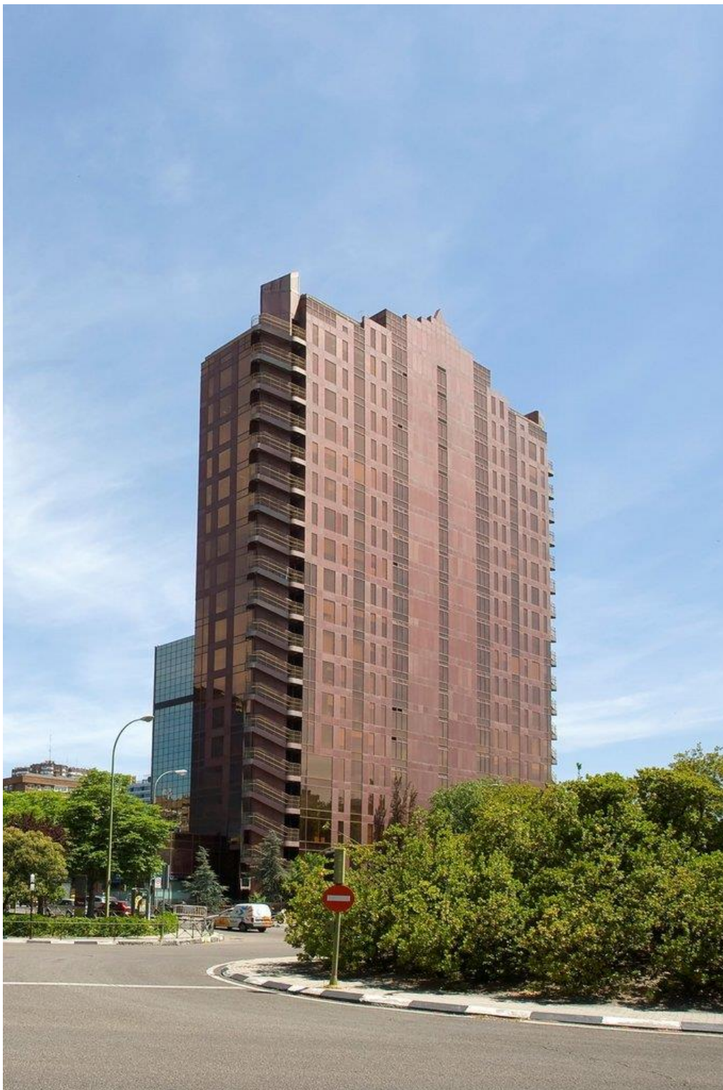
Edificio situado en la av. de Burgos, Madrid:
