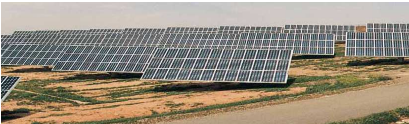
1,2MW Solar FV Planta en Tudela (España)
