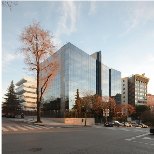
Foto: Edificio Ramírez de Arellano 15, propiedad de Axiare Patrimonio
