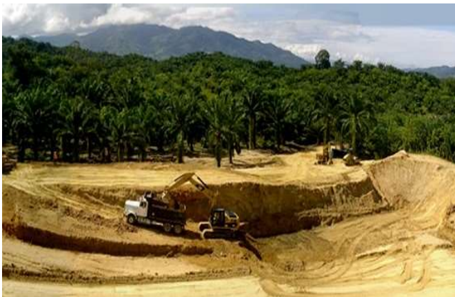
Proyecto construcción y equipamiento del relleno sanitario El Pinalito, (Honduras). Ejecución 2016-2017
