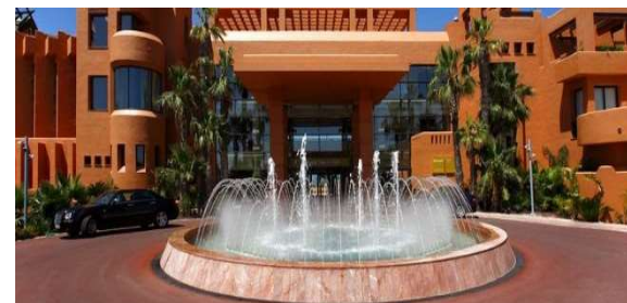
Gestión y venta de energía térmica con calderas de biomasa en el Hotel Barceló Sancti Petri spa resort (España) 2015-2025
