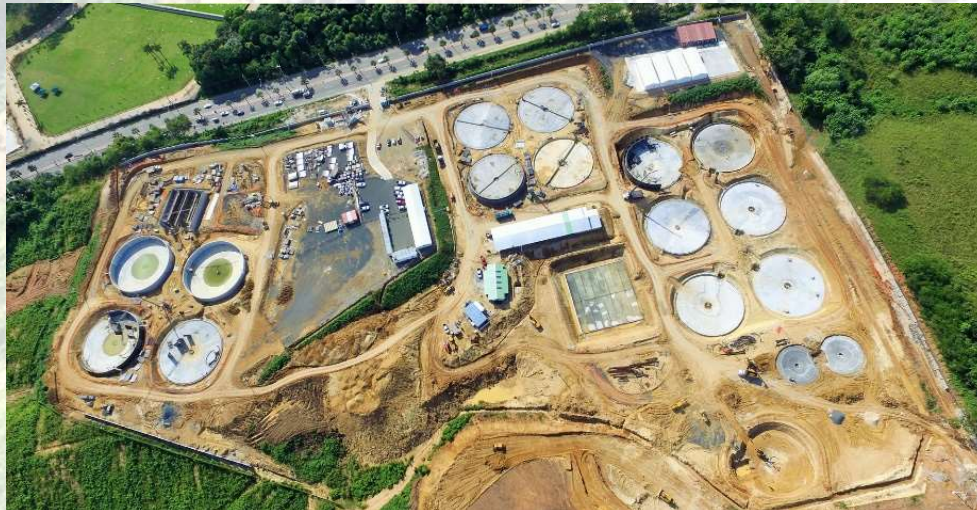
Proyecto construcción de la depuradora del río Ozama (Rep. Dominicana). 2016-2018
