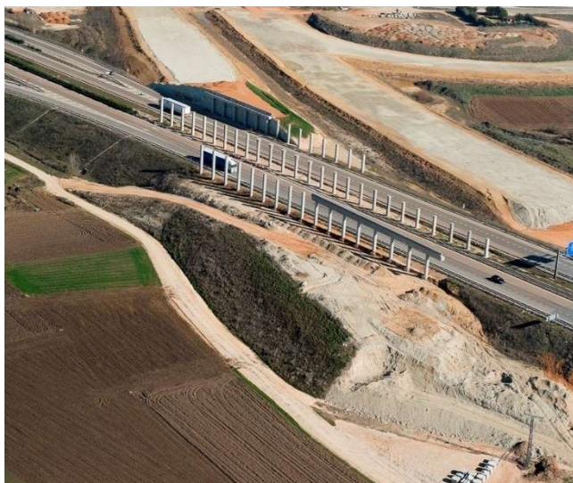
Proyecto de Consultoría y Asistencia Técnica para Control y Vigilancia de la Circunvalación de Burgos BU-30. España
