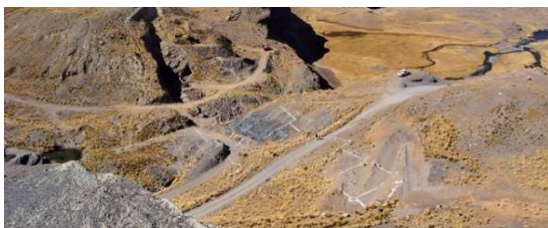
Supervisión de las obras de construcción de la represa de La Paz. Hampaturi Alto (Bolivia). 2015-2017
