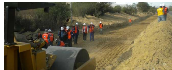
Supervisión técnica y ambiental de la construcción de la doble vía al valle Alto tramo: Angostura – Paracaya (Bolivia) 2015-2018
