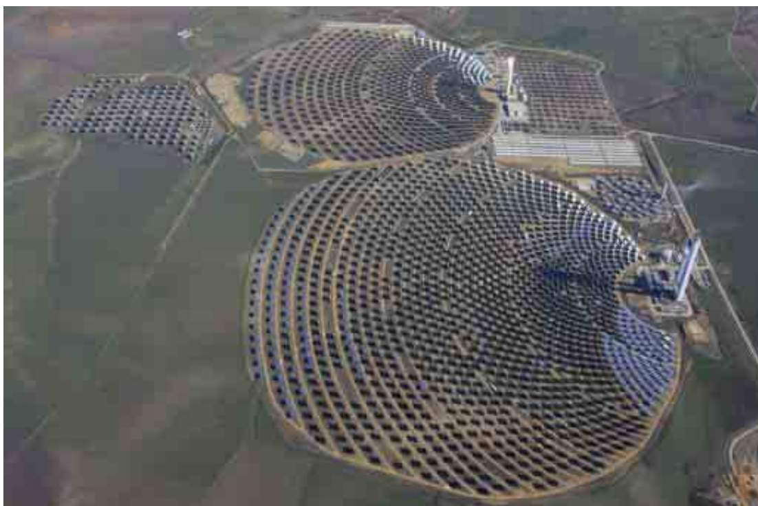
Plataforma solar con instalaciones de diversas tecnologías
