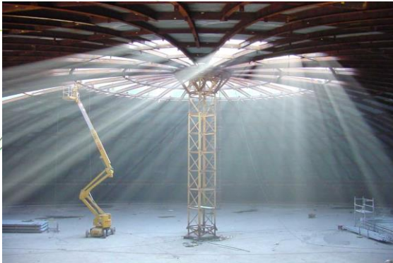
Tanque Sales Fundidas
