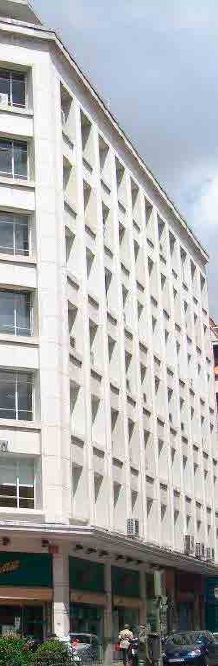
◆ Edificio de Oficinas Eloy Gonzalo (Madrid)
