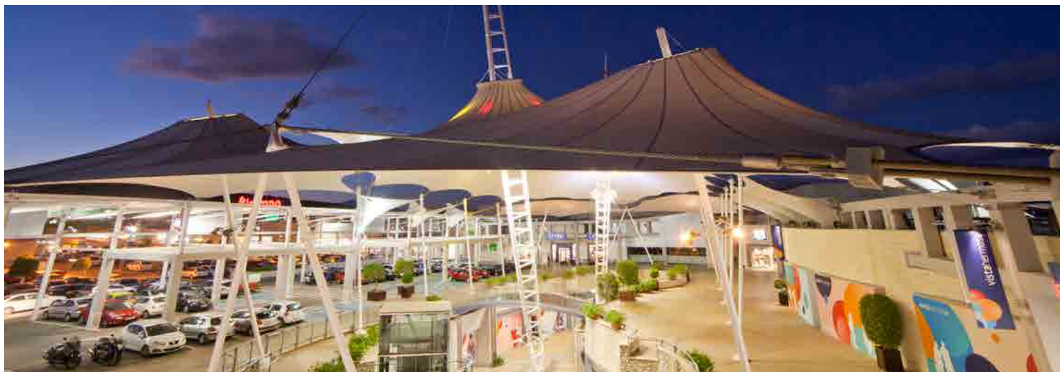
Centro Comercial Vistahermosa (Alicante)
