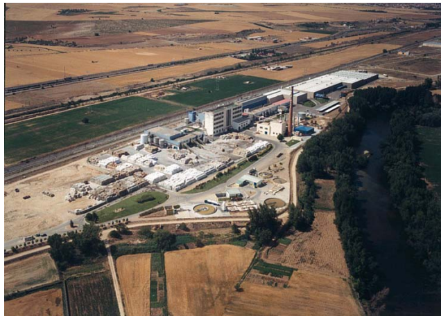
Dueñas - Palencia (España)- Vista aérea Papel-Cartón-Cajas-Cogeneración
