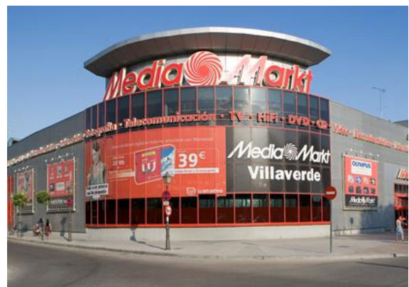
Fachada Principal del edificio Comercial
