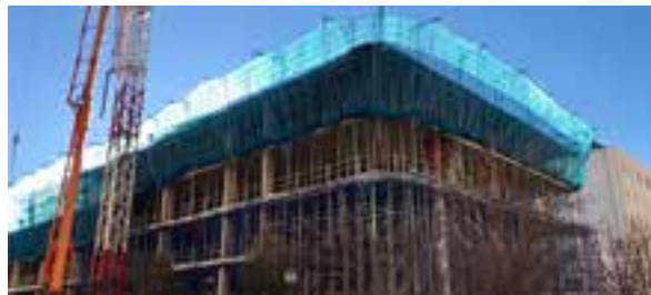
Obras en residencial Lagasca 99 (Madrid)
