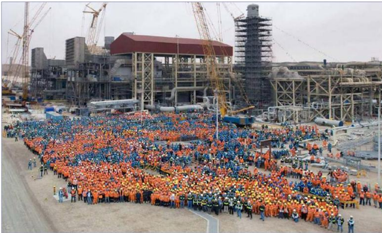
5,000 CB&I employees on Process area (octubre-09)
