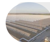
50 Mw Planta termosolar de Puertollano
