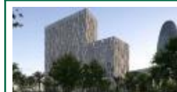
Avda. Diagonal, 197 Barcelona
