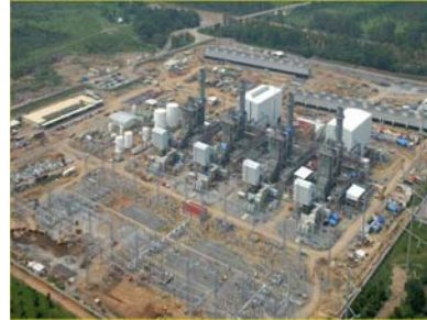
Ciclo Combinado de Tamazunchale, 1.135 MW (México) Proyecto llave en mano; en operación en 2007
