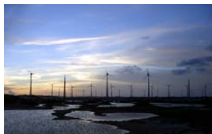
Parque eólico Rio do Fogo 49,3 MW (Brasil) Proyecto llave en mano
