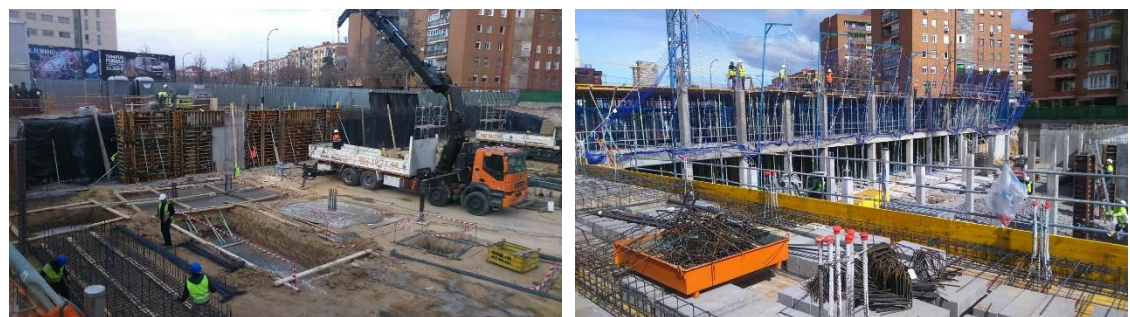
Progreso de obra
