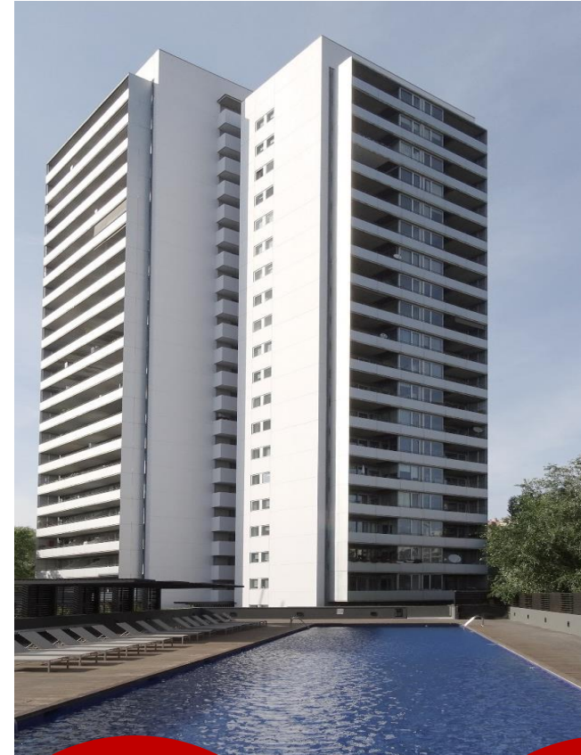
ISLA DEL CIELO (post-reforma)
