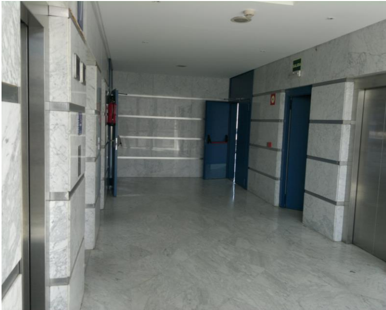
EDIFICIO MURANO (pre-reforma)
