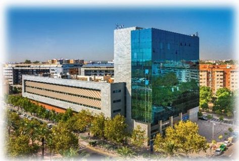
Edificio Insur (Sevilla)
