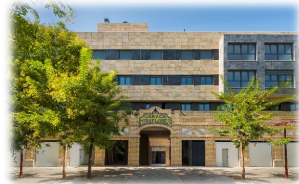
Edificio Miraflores (Sevilla)
