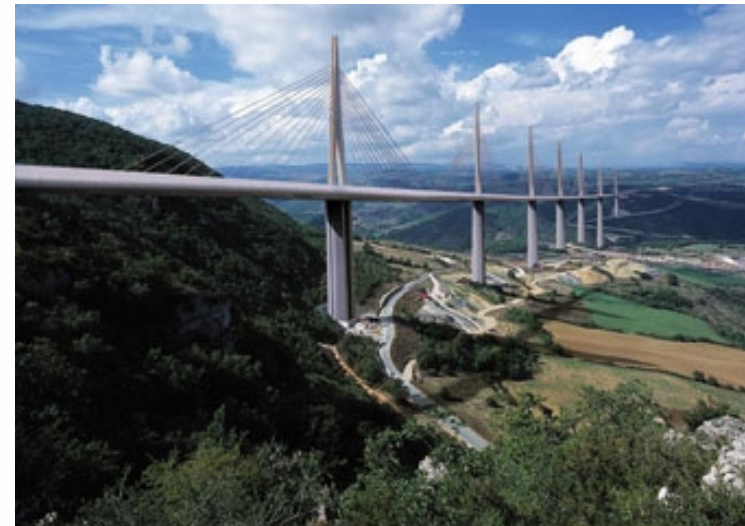
Viaduct Millau. Francia
