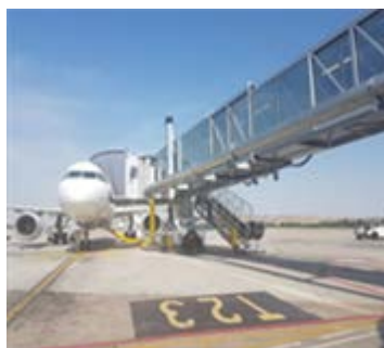
Imagen 27. Nueva pasarela. Aeropuerto Adolfo Suárez Madrid-Barajas
