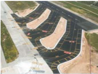
Imagen 19. Nuevas calles de acceso. Aeropuerto de Palma de Mallorca
