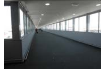
Imagen 17. Renovación pasarela RENFE. Aeropuerto de Barcelona
