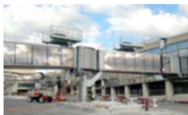
Imagen 28. Nuevas pasarelas en el aeropuerto de Málaga
