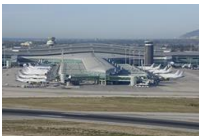
Imagen 2. Plataforma - Aeropuerto Barcelona-El Prat
