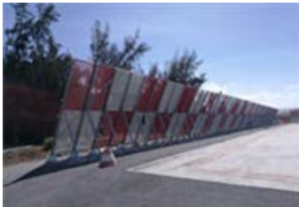
Imagen 20. Barreras anti-chorro. Aeropuerto de Gran Canaria
