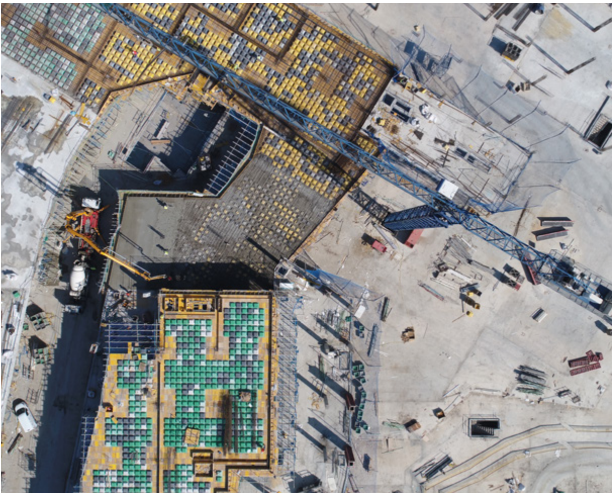
Avances de obra en Palmas Altas (Sevilla)
