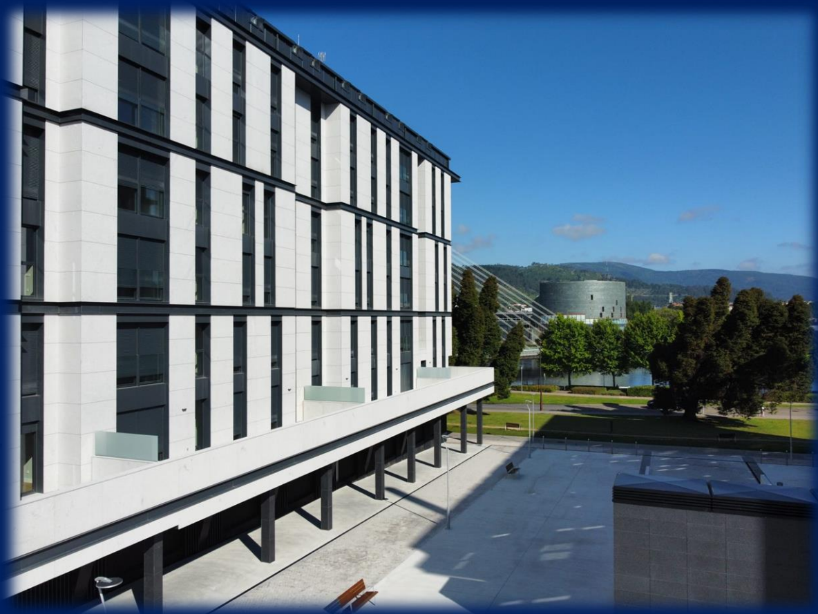
Residencial Novolerez (Pontevedra)
