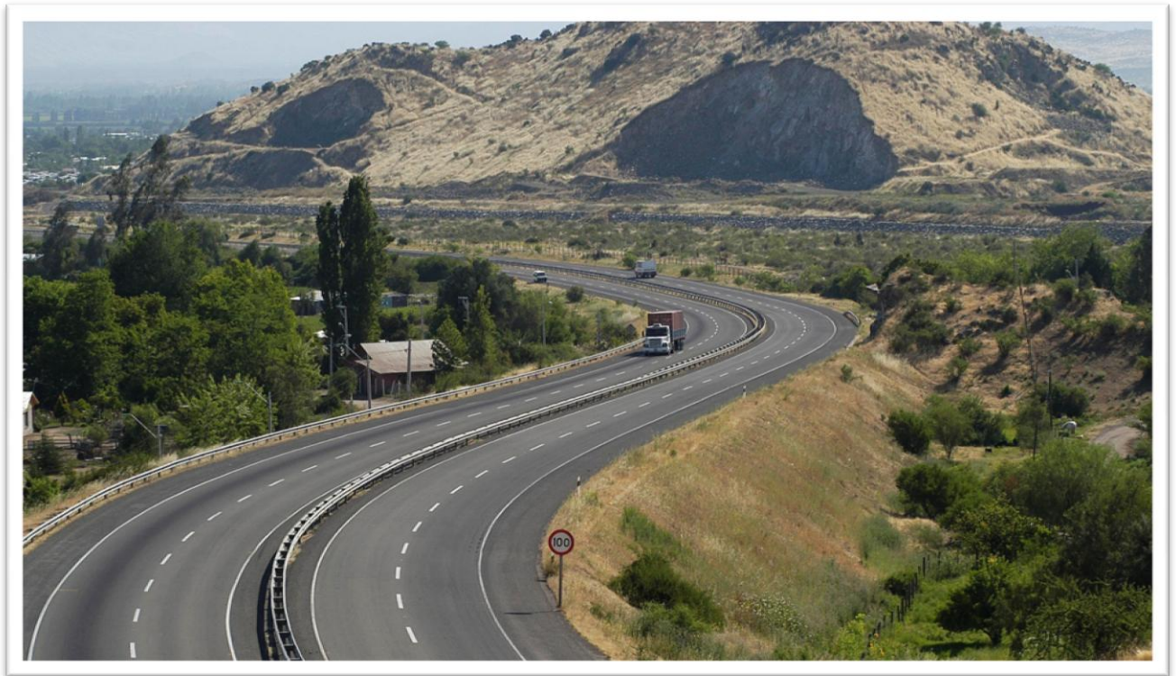
Autopista Libertadores - Chile
