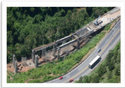
Duplicación de Serra do Cafezal (Autopista Régis Bittencourt)
