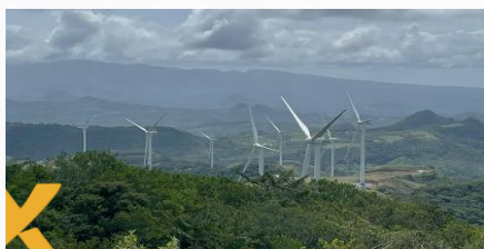
Parque eólico Toabré (Panamá) 66 MW
