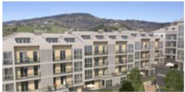
Edificio Usúrbil Fase 1 28 dwellings
