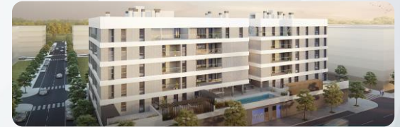
Residencial Mulhacén (52 units)
